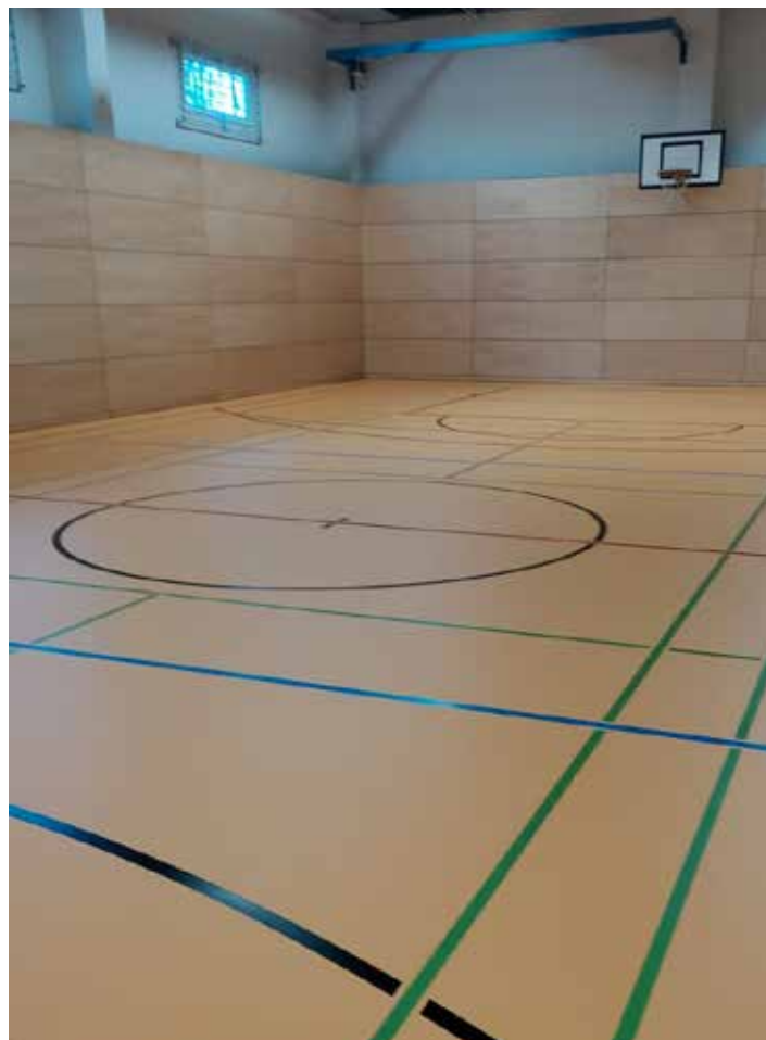
Neu eingebrachter Fußboden
