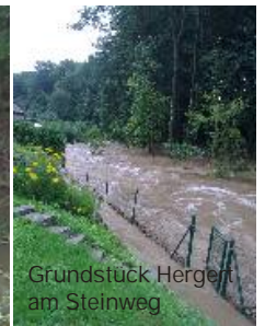
Zerstörte Brücke zur Meßstation Steinweg
